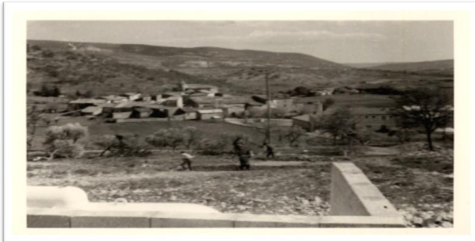
Construction du hameau de forestage d'Ongles, Alpes-de-Haute-Provence, dr
